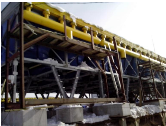
Рис. 1. Монтаж АВО на компрессорной станции магистрального газопровода
